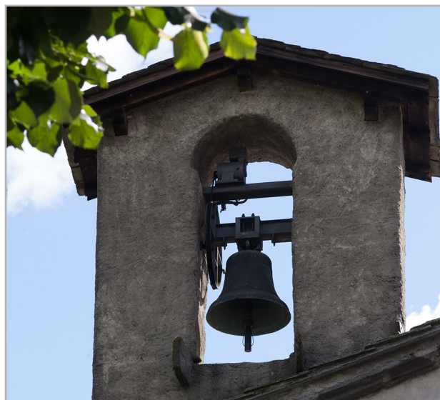
L'unica campana della piccola cella campanaria innalzata in continuità con la parete di fondo alla destra dell'abside (foto: M. Brigatti)
